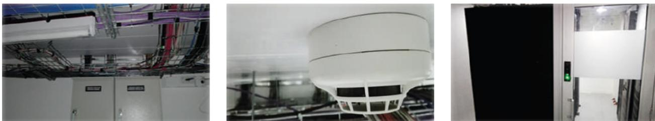
En la adecuación del centro de cableado, se organizaron los equipos tecnológicos en los racks y se realizó el peinado y etiquetado del cableado permitiendo la localización de los puntos de red de manera segura, rápida y precisa. Se realiza el reemplazo total del cableado categoría 5 por cableado estructurado en categoría 7A certificado.
