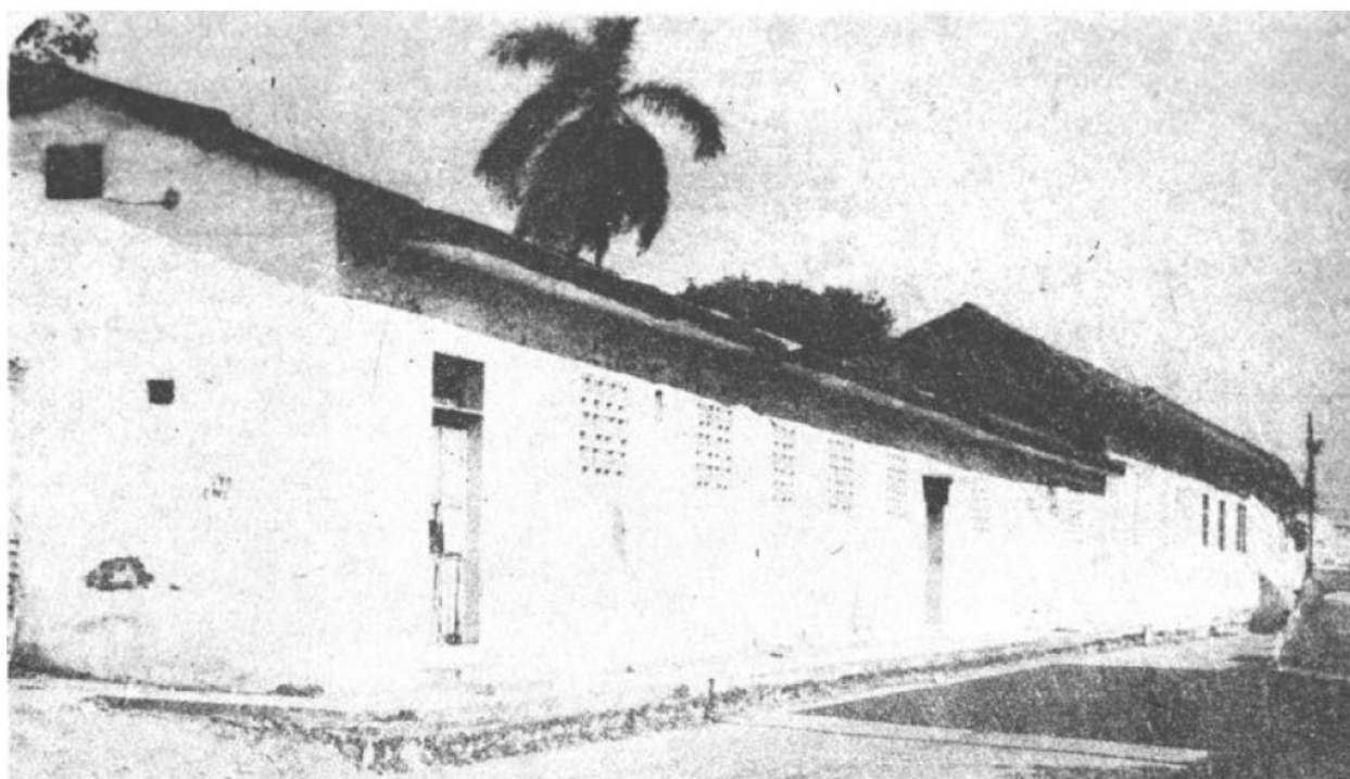
Fachada principal del viejo caserón de propiedad de la Sociedad de Beneficencia y Caridad, el que sirvió de sede al antiguo Hospital San Miguel. Fuente: Diario del Huila, febrero 2 de 1978.
