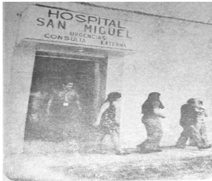
Puerta de Urgencias del Hospital San Miguel Fuente: Diario del Huila, marzo 23 de 1980.
